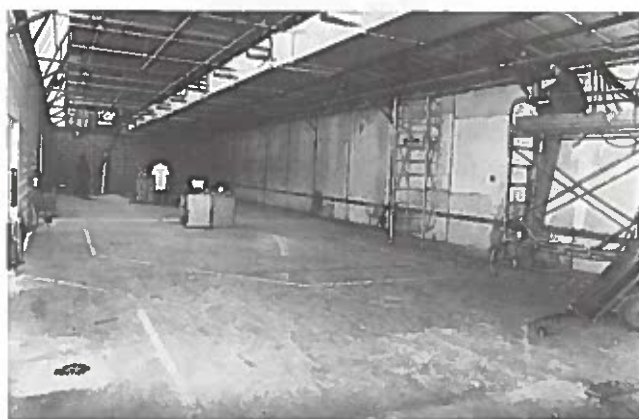
l'atelier en construction
